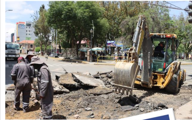
Trabajos en la plaza
